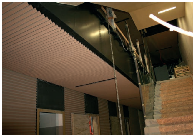
Podhledy a obklady na chodbách
